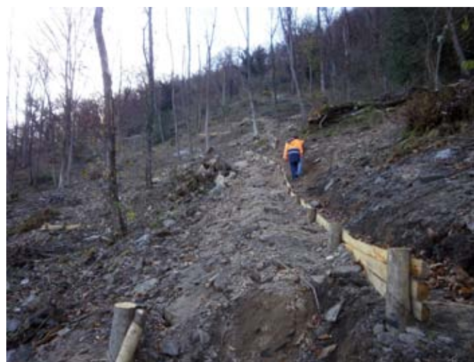
Lavori idraulici a Capon.
