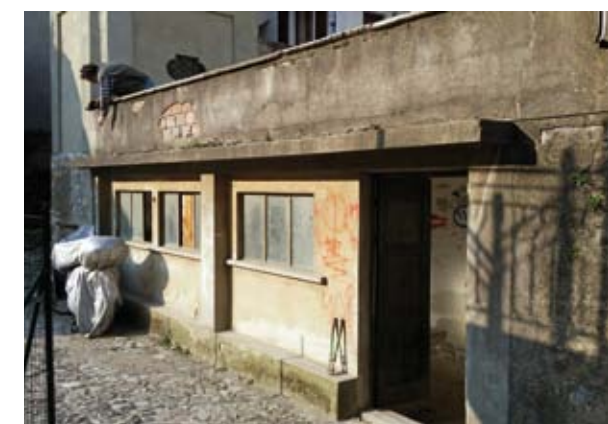
Il lavatoio di Toriggia (esterno) prima e dopo gli interventi.
