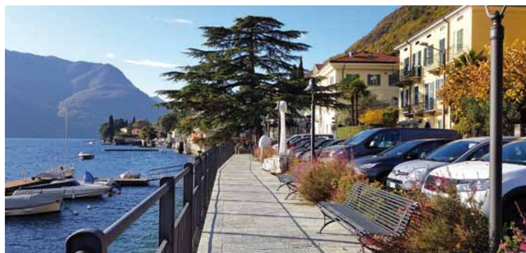
Il Lungolago terminato e, a fianco, una fase dei lavori.
